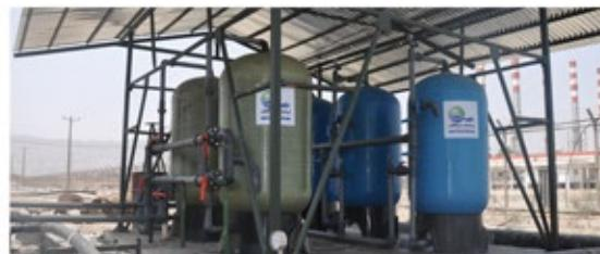
• **فیلترهای کربنی** Activated Carbon فیلترهای کربن (زغال فعال شده) (Activated Carbon) مخصوص حذف مواد شیمیایی، طعم و حذف کار اضافی و باقیمانده. جنس بدنه فیلتر های زغال از ورق استیل، FRP و یا ورق کربن استیل می باشد. جنس بستر فیلتر از زغال فعال شده می باشد. کاربرد عمده فیلتر زغالی در پیش تصفیه RO - فیلتراسیون آب معدنی، فیلتراسیون آب شرب و حذف طعم، رنگ، بو، کلر، مزه و مواد شیمیایی می باشد.
